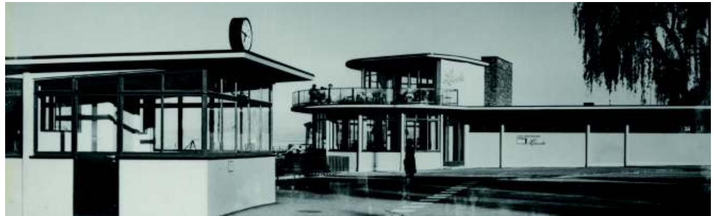
Schaltzentrale und Ländebauten von Norden, 1953
