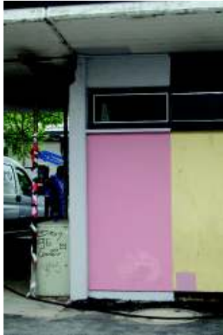
Musterachse zum Neuanstrich nach Befund mit Freilegungsfeld, Mai 2008
